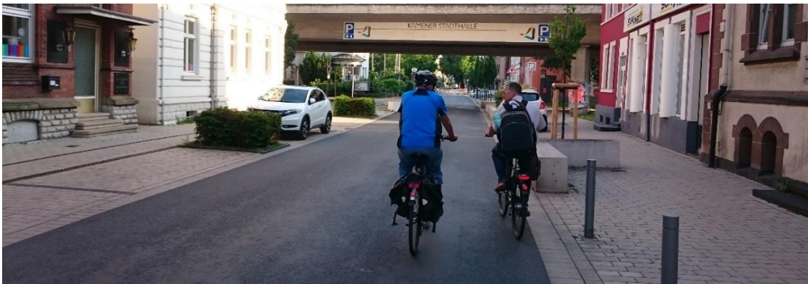
Abbildung 29: 5m breite, bituminöse Fahrbahn der Fahrradstraße (Kamen)
