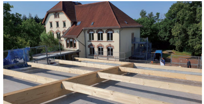
Das neue Dach der Turnhalle wird im September fertiggestellt.
