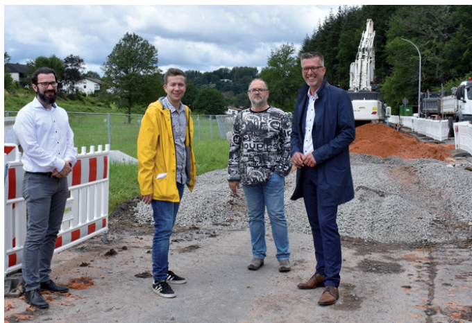
Michael Arend, Leiter des Bauamtes, Sebastian Thul, Staatssekretär, Roman Backes vom Bau- und Umweltamt und Bürgermeister Bernd Huf besichtigen die Bauarbeiten.
